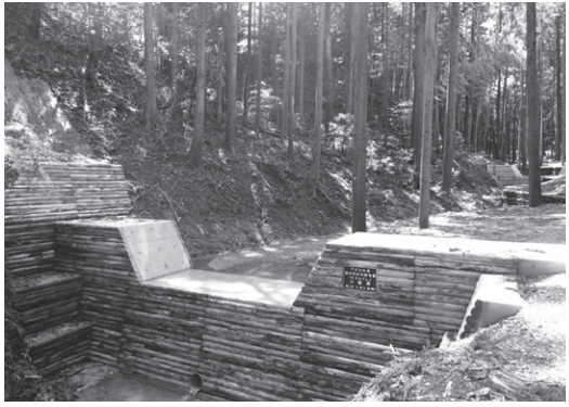
治山ダムの整備
