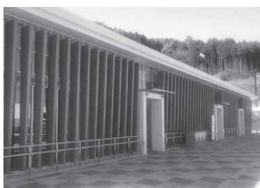
パーキングエリア建物外観
