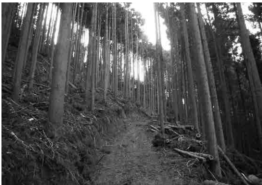
作業路の開設
