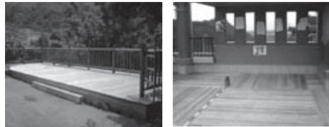
設置された木製展望デッキなど
