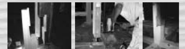
柱の傷んだ部分を改修
