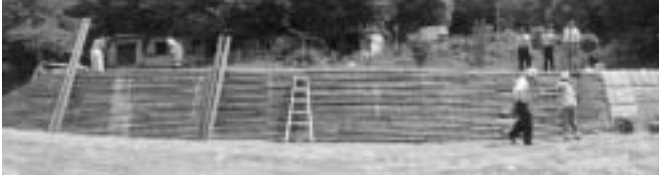
導流堤(写真をコンピュータでつなげています)
