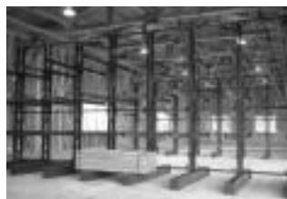
丸棒保管倉庫の内部
