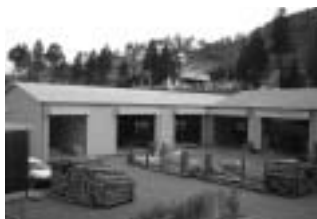
完成した丸棒保管倉庫
